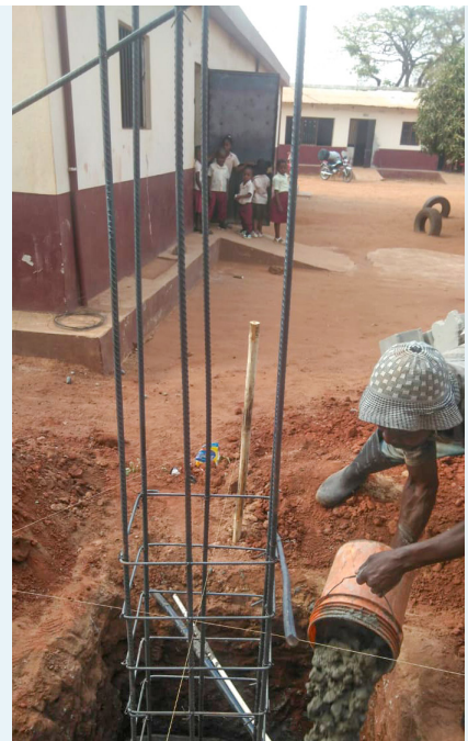
Obras de construção do depósito de água
